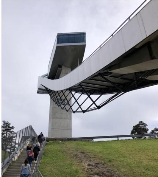
*Abb. 17: Stahlunterkonstruktion der Anlauframpe und auskragender Panoramabereich<sup>17</sup>*
