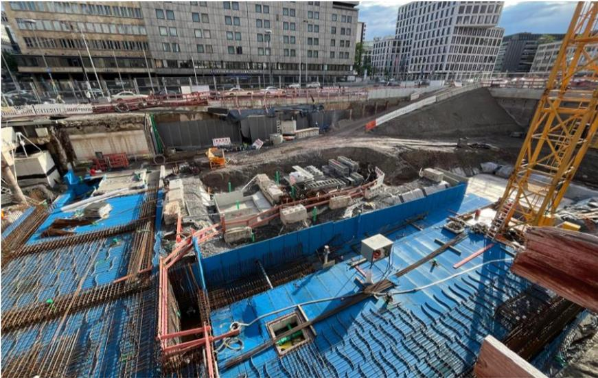
*Abb. 23: Baugrube für das Versorgungsgebäude<sup>2</sup>*
