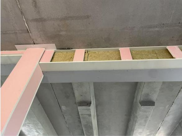
*Abb. 5: Brandschutzverköfferte Bauteile<sup>5</sup>*
