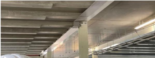
*Abb. 4: Rippendecke und Flurdecke<sup>4</sup>*
