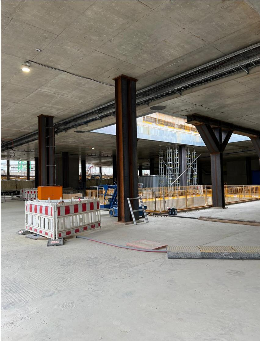
Abb. 12: Temporäre Stützen<sup>7</sup>
